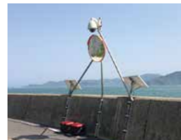
海岸沿い道路の地すべり監視
