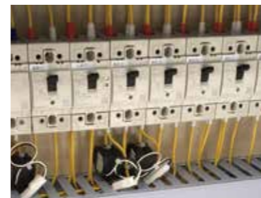
ブレーカーの電流値計測
