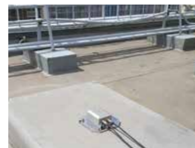
高層ビルのヘルスマニタリング
